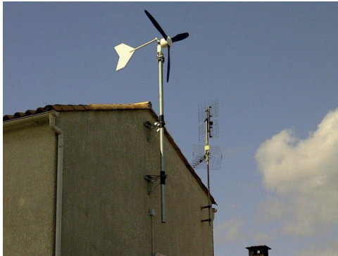
Mini-éolienne (1 à 3 kV) fabriquée avec des matériaux locaux pour faciliter l'accès à l'énergie électrique à moindre coût des foyers ruraux en Guinée
